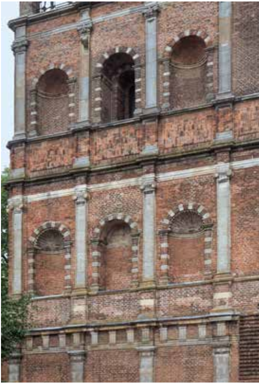
Langs de vierkanten zijn in de pilasters van onder af duidelijk Dorische, Ionische en Korintische zuilen te herkennen.
