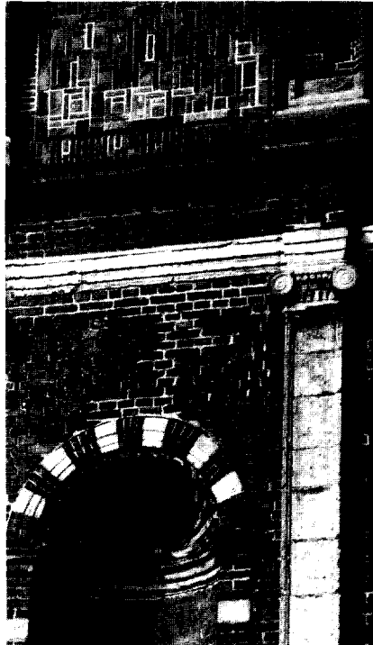
1a. Détail van de voorgevel van de kerktoeren te IJsselstein.
